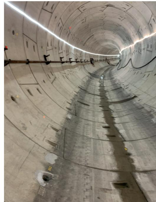
tuent le revêtement final du tunnel au fur et à mesure de l'avancée.
