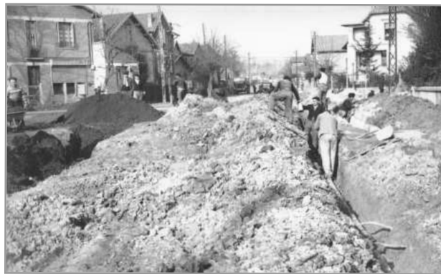
L'avenue du Lauragais en pleins travaux dans les années 1950 (source : TOULOUSE, les années 1950-1960, éd. Loubatières)
